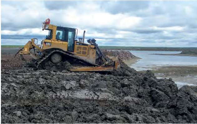
Рис. 3. Формирование отвала обезвоженных глинистых хвостов
