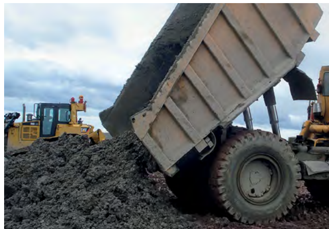
Рис. 2. Доставка обезвоженных глинистых хвостов на складирование
